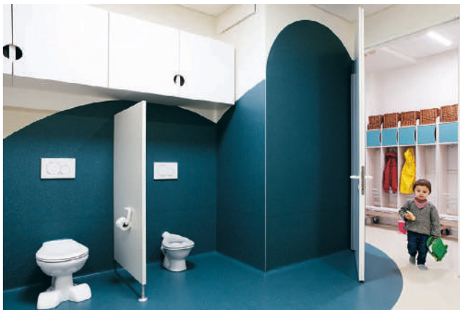
Bild 8. Kautschuk ersetzt im WC den Fliesenspiegel (Fotos 1, 3-8: HEJM)
