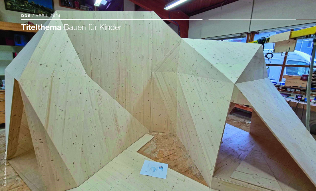
Testaufbau des Kletterbergs in der Holzwerkstatt Häring. Eine zweite Ebene mit Netz und einer Rampe passte das Team hier ein
