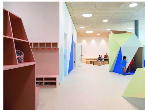
Die akustisch wirksame Decke aus Holzwolleleichtbauplatten sorgt im Raum für eine angenehme Atmosphäre
